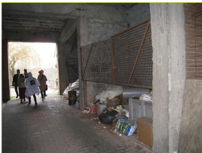
Dépôts sauvages - rue Stephenson 2018 – © RenovaS
